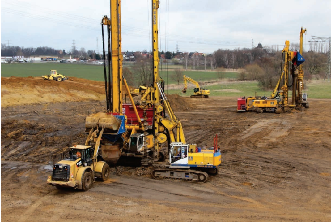
Abb. 3 – Herstellung von Rüttelstopfsäulen an der Eula-Querung mit einer BAUER BG 40 und BAUER BG 28 (© BAUER Spezialtiefbau GmbH)
