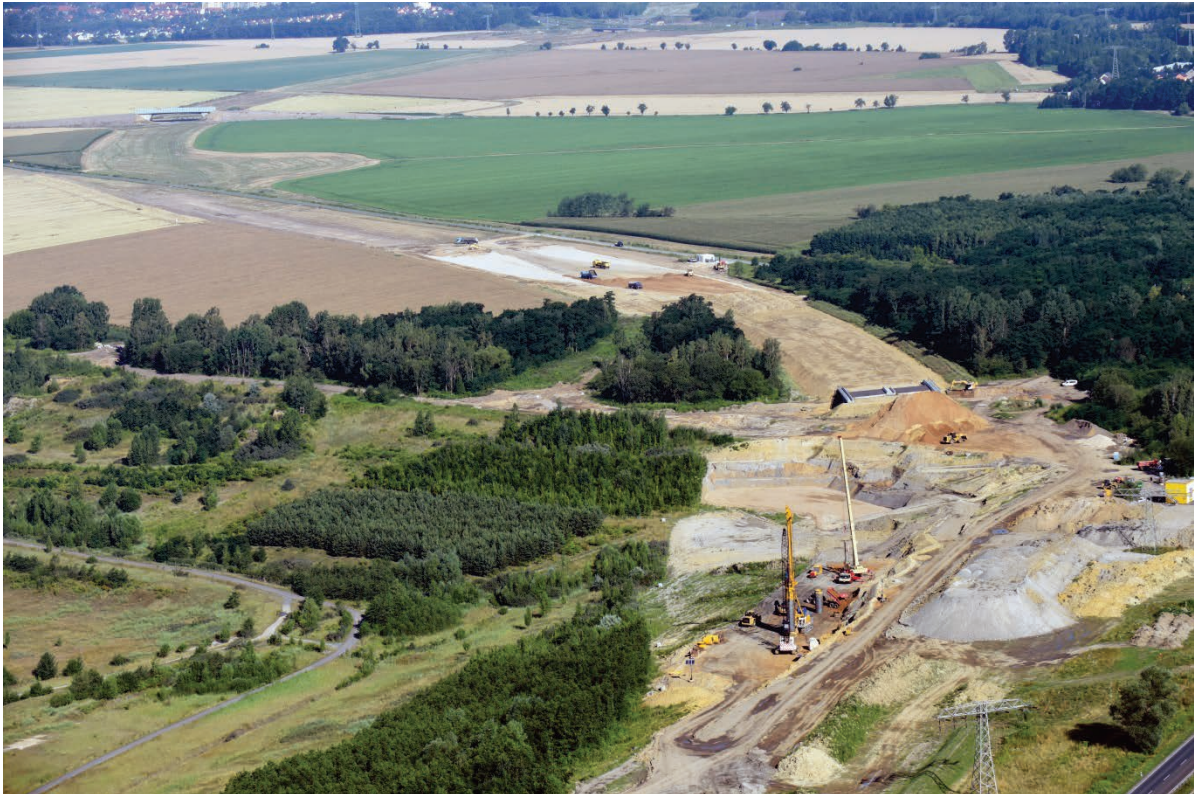
Abb. 1 – Übersicht des Bauabschnitts 5.1 der Bundesautobahn A 72 von Borna bis Rötha (© euroluftbild.de)
