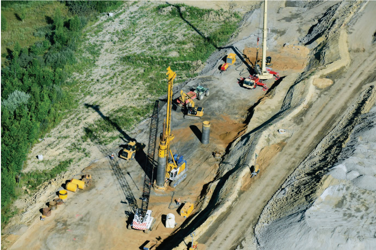
Abb. 4 – Bodenaustauschbohrungen mit einer BAUER BG 46 im Kelly-Verfahren (© euroluftbild.de)
